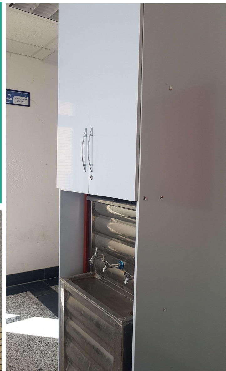
نصب باکس برای آب سردکن
