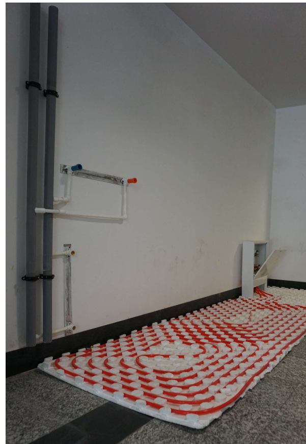
سیستم گرمایش از کف
