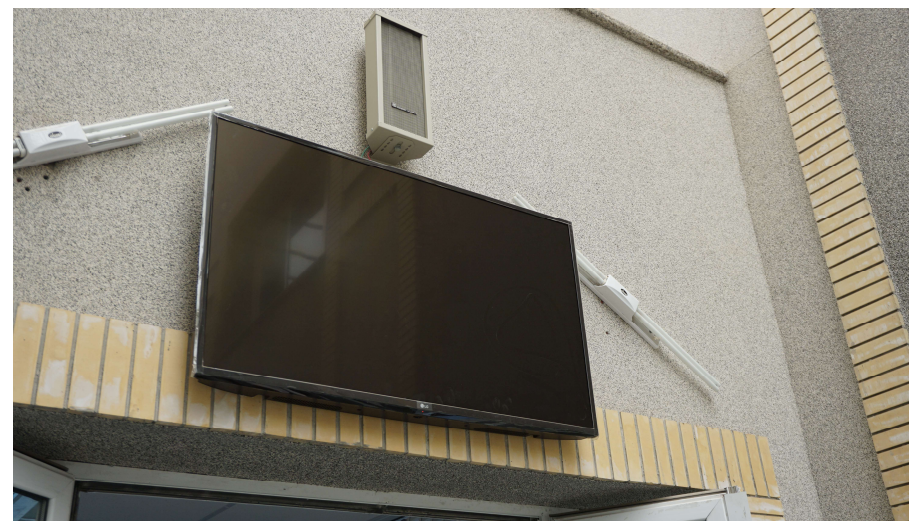
نصب سامانه اطلاع رسانی در آتریوم
